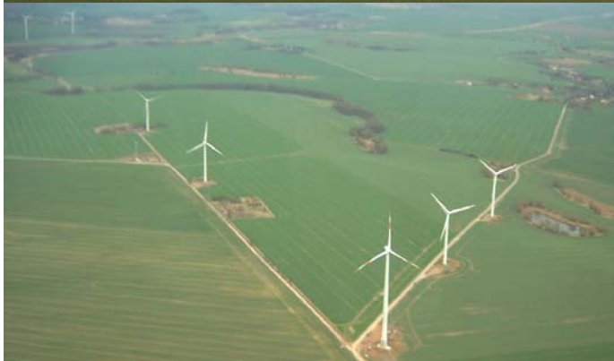
Oben die in Reihe senkrecht zur Haupt-Windrichtung stehenden K 6 – K10 mit 77 m Rotor auf 100 m NH – alle im flachen Gelände der Uckermark nördl. Prenzlau.
